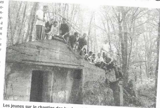
Les jeunes sur le chantier des bunkers à Burnhaupt-le-Bas. (Photo DNA)
